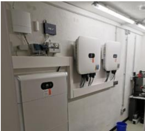
Wechselrichter, Batteriespeicher, PV-Anlage
