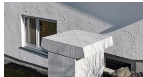
Luft-/ Wasser-Wärmepumpe
